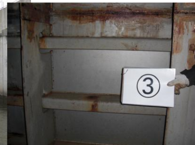
ローラーゲートの腐食
