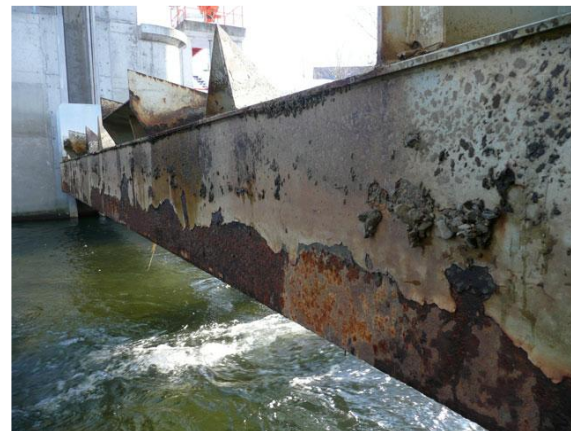
土砂吐きゲートの腐食
