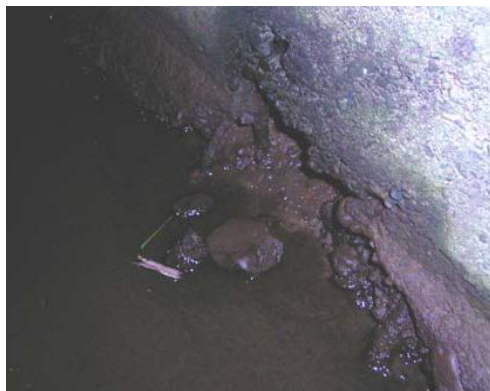
函体コンクリートの劣化
