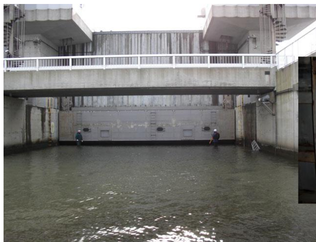
ローラーゲートの腐食
