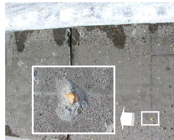
ポップアウト(骨材膨張)
