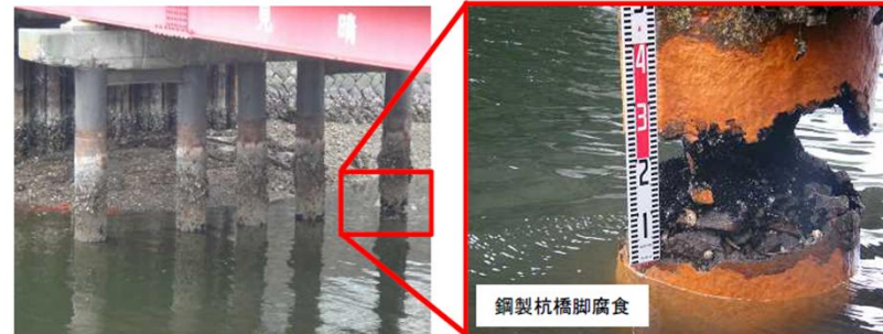
【重大な損傷の事例(橋梁)】
