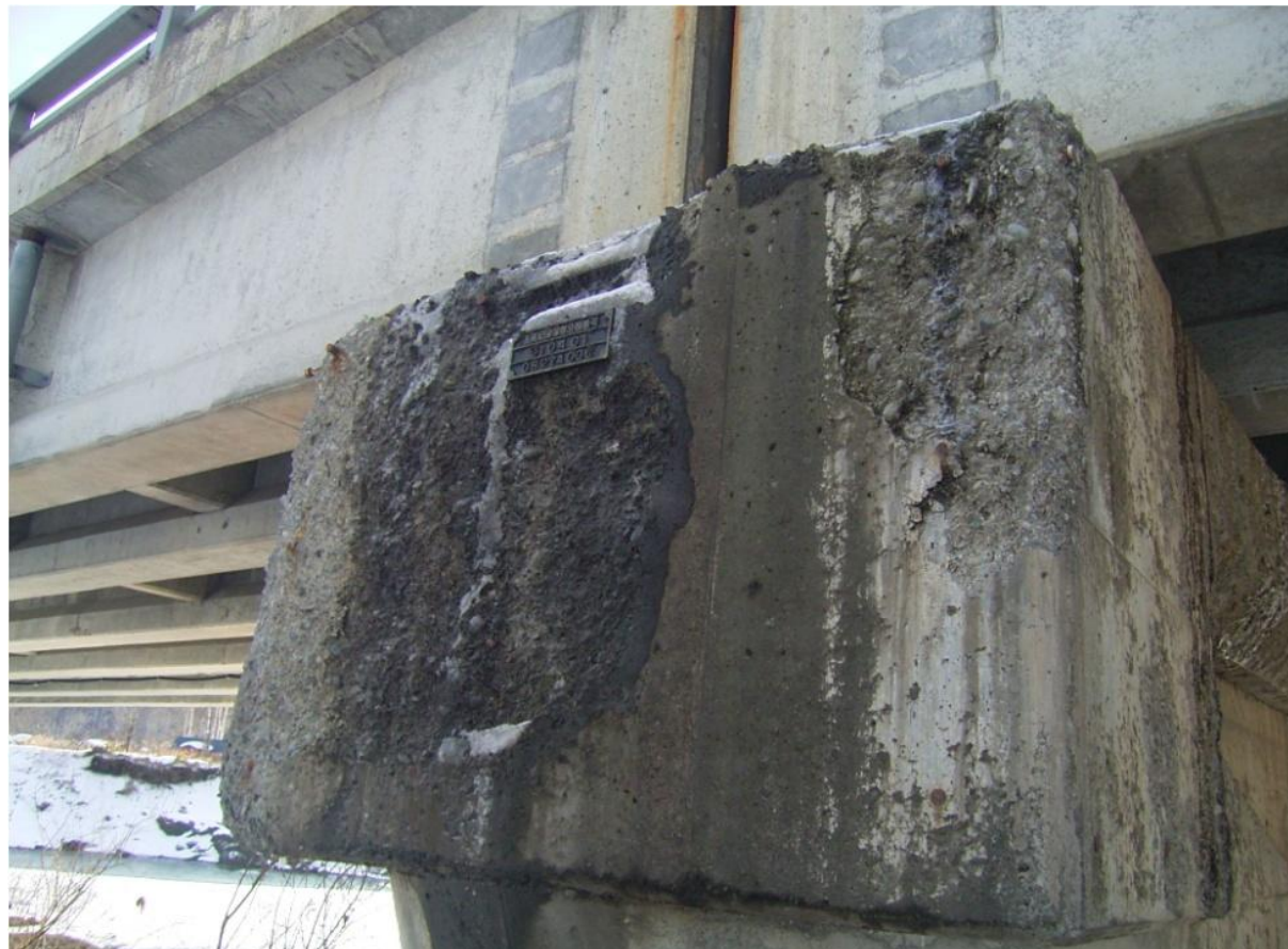
凍害と塩害の複合によって劣化した橋脚の事例
