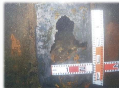
矢板が腐食した係留施設の老朽化対策例
