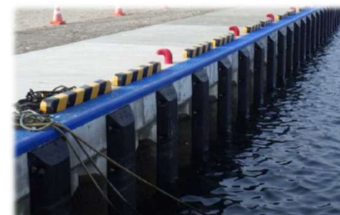
矢板が腐食した係留施設の老朽化対策例
