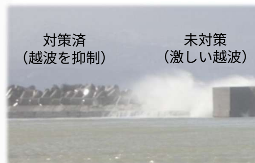
消波ブロック嵩上げによる越波抑制効果例
