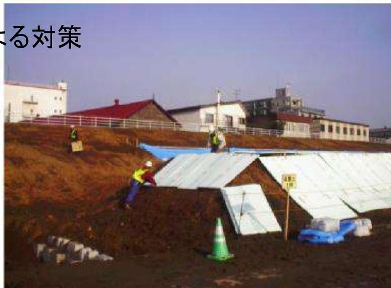
断熱材による断熱
