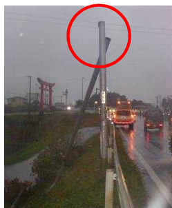
・溶接継ぎ手部の破断
