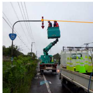
・高所作業車による点検
