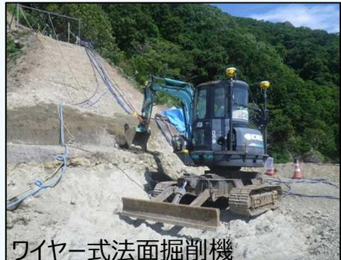
ワイヤー式法面掘削機
